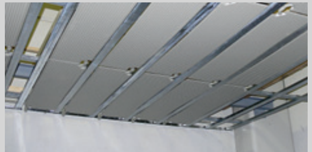
Bien Colocado - módulo de techo climatizado.
