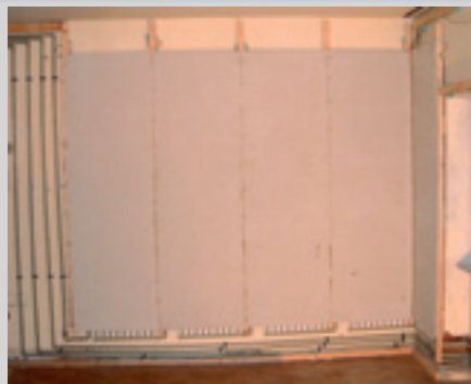
Modernización de un departamento antiguo con Hitherm® Compact.
