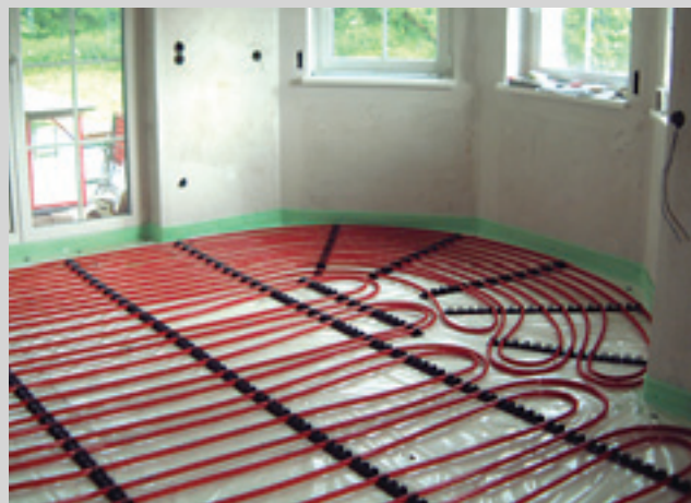
Aplicación en interiores: calefacción de suelo Euroval® para un clima ambiental agradable.
