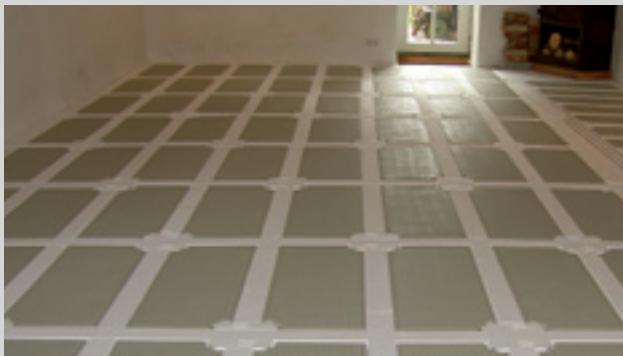
Bien Colocada: módulo suelo climatizado.
